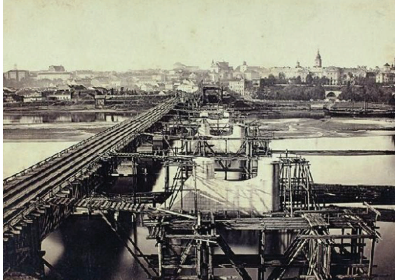
Tak wyglądała budowa warszawskiego mostu Kierbedzia w 1862 r.
